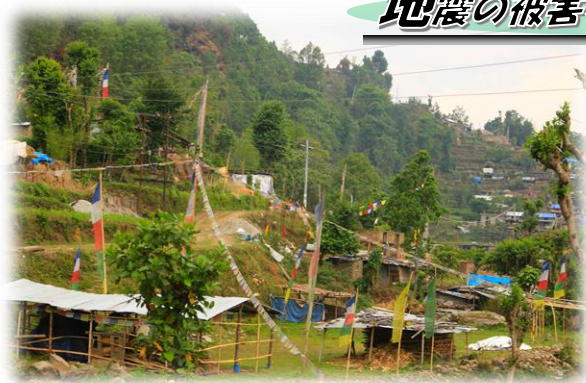
2015年の地震の被害を受けたシンドウパルチョーク郡ラタンコト村
